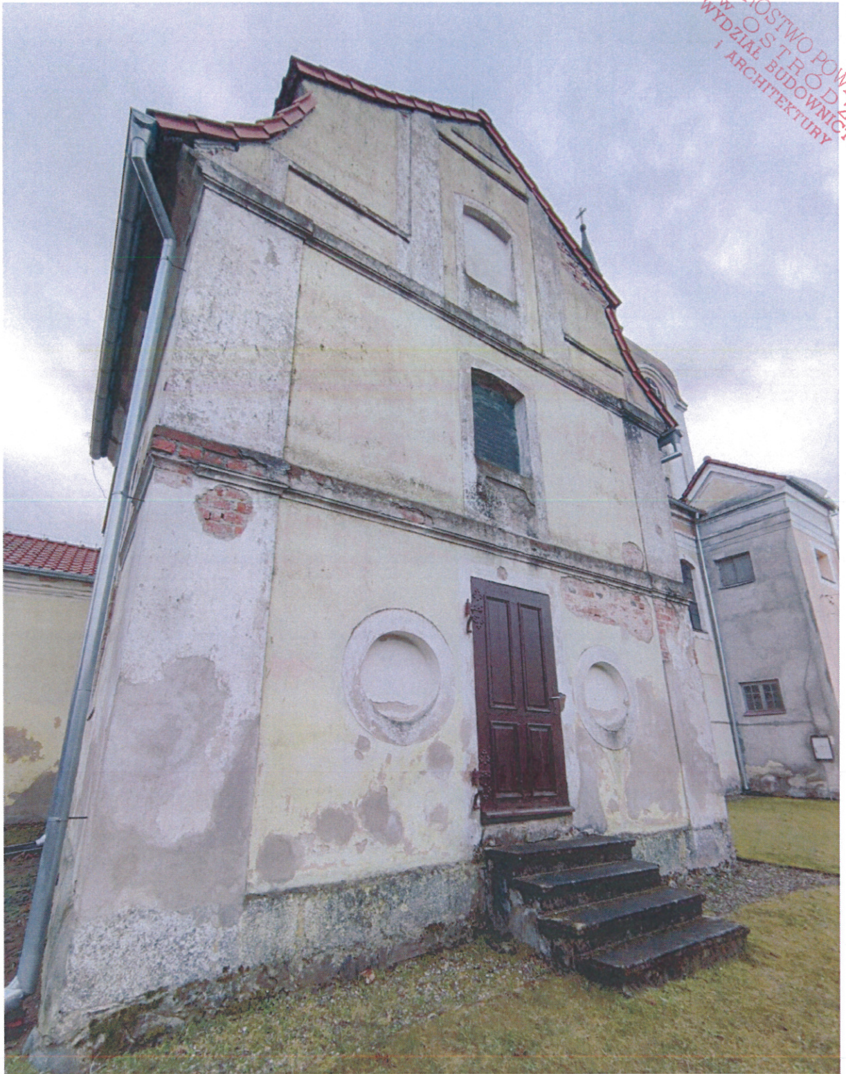
Zdjęcie 13. Widok na elewację północno-zachodnią zakrystii.
