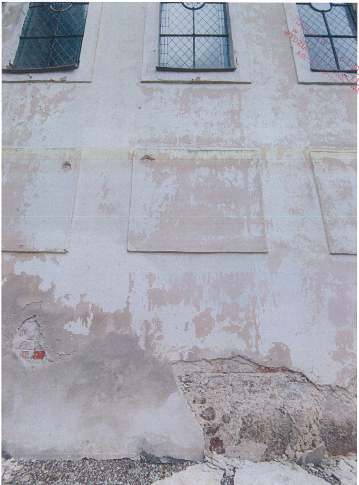
Zdjęcie 18. Fragmentu ściany od strony południowej. Na zdjęciu widoczny kamienny cokół, który został pokryty tynkiem wapienno-cementowym oraz ściana z cegły powyżej.
