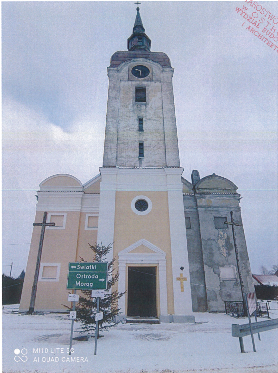
Zdjęcie 1. Elewacja frontowa zachodnia
