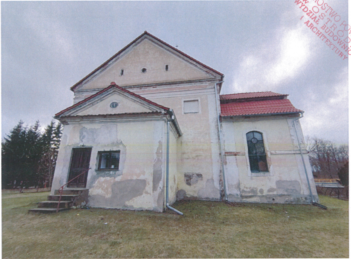
Zdjęcie 10. Widok od strony wschodniej na kaplicę i zakrystię.
