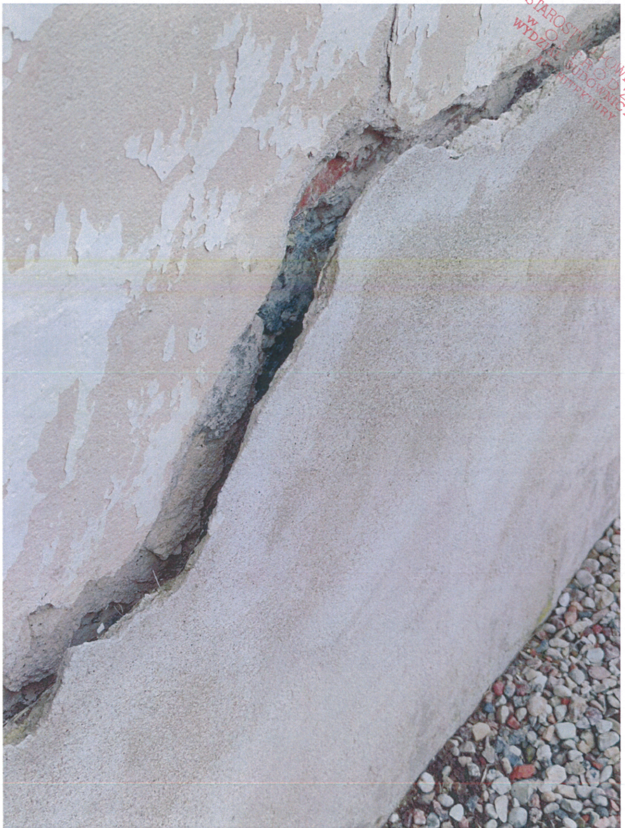
Zdjęcie 15. Zbliżenie na otynkowany cokół od strony południowej.
