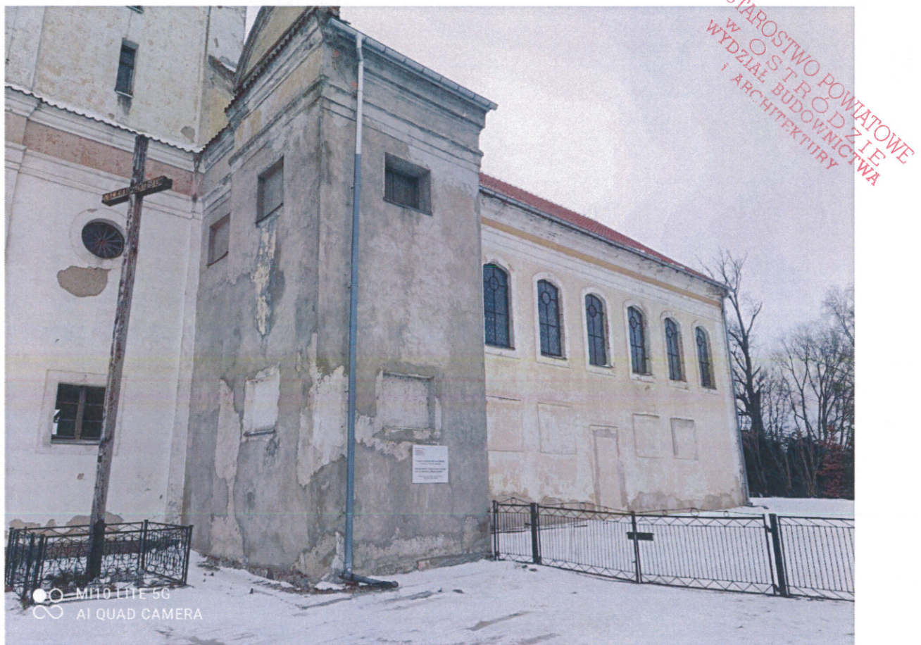
Zdjęcie 2. Widok od strony południowej na wieżę schodową i fragment elewacji
