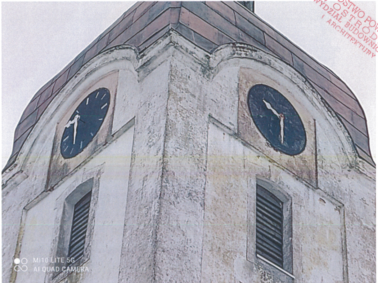
Zdjęcie 6. Zbliżenie na hełm wieży głównej
