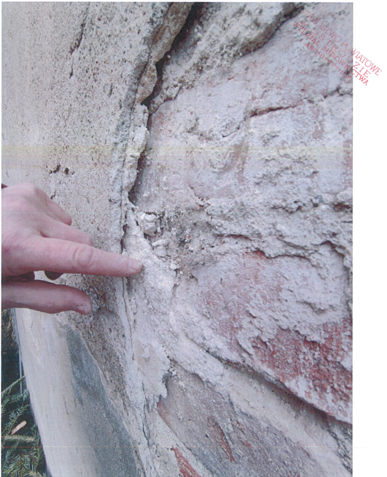
Zdjęcie 17. Fragmentu ściany z odkutym tynkiem od strony południowej, widoczna cegła.
