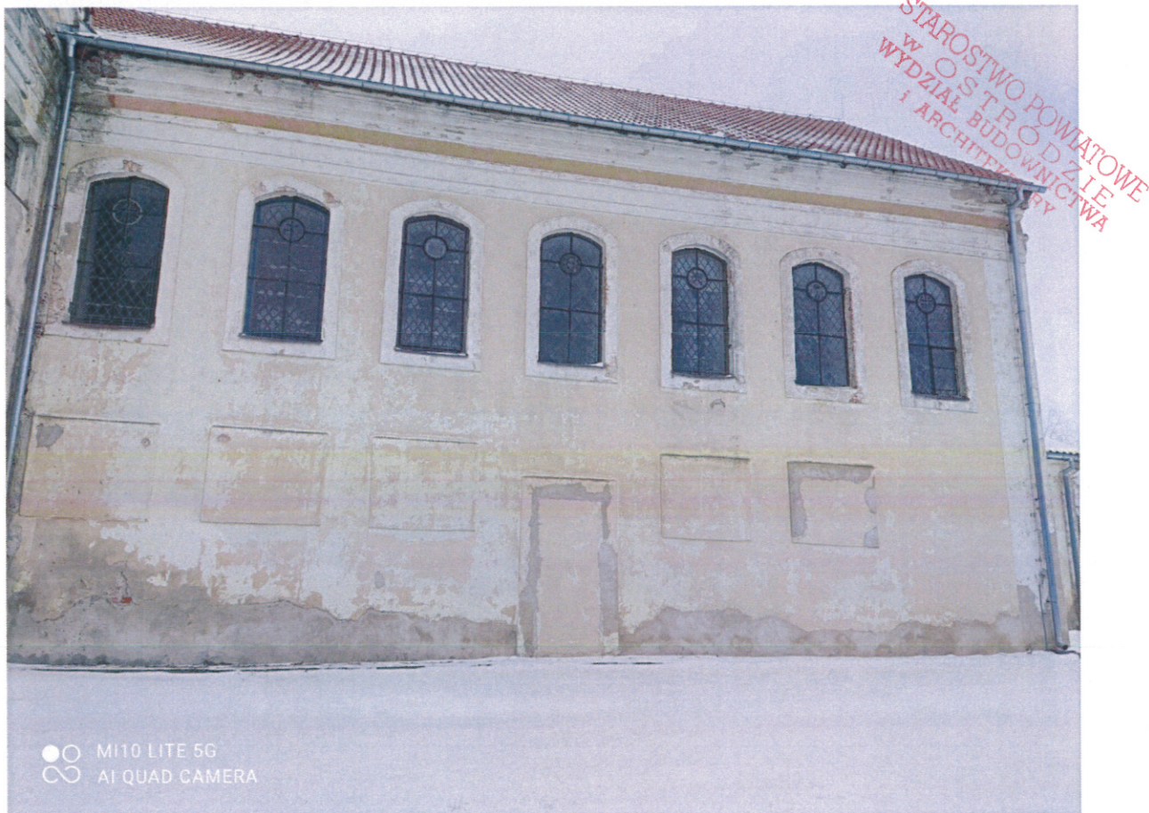
Zdjęcie 8. Elewacja południowa
