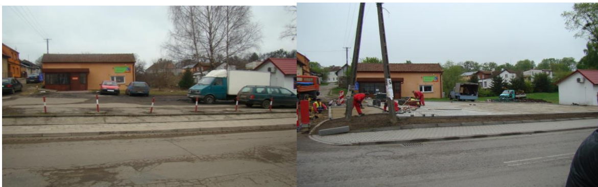
Fot. 14,15. Parking przy ulicy Świerczewskiego przed i po remoncie.
