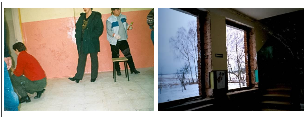
Marzec 2003 rok – rodzice wyremontowali stołówkę szkolną (położyli terakotę i odnowili ściany)
